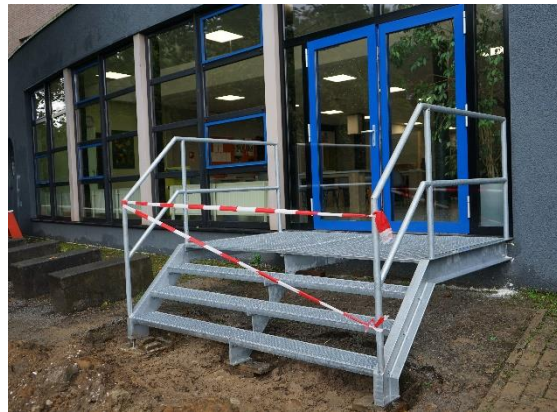
De trap bij de nieuwe ingang is geplaatst, de afwerking volgt
